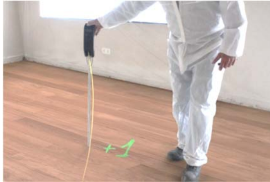
Figure 3 : Contrôle du support et marquage au sol sur le plancher support
